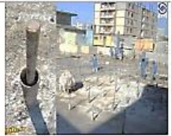
نصب آرماتور تسلیح قبل از گیرش سیمان
