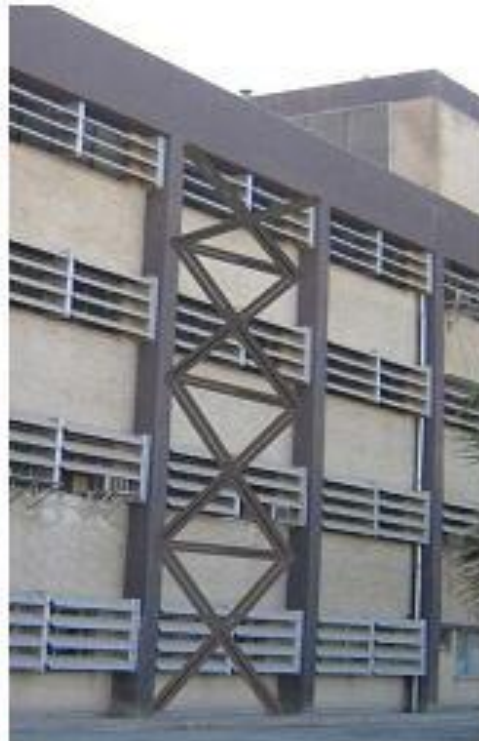
شکل ۳-۴- استفاده از مهاربندها بصورت نمایان در ساختمان‌ها
