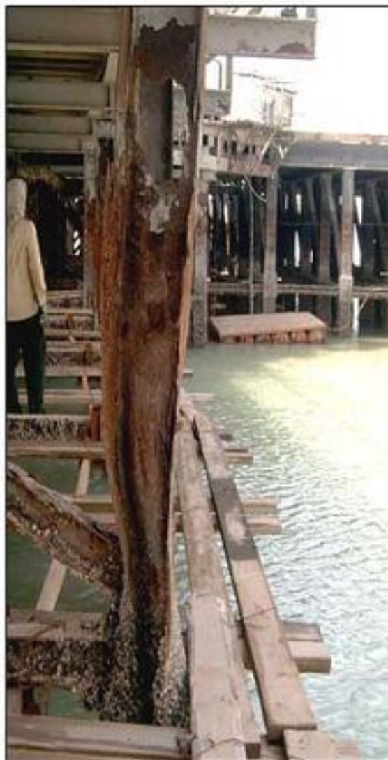
شکل ۲-۵-۲۳- بهسازی ستون‌های با خوردگی شدید با روکش بتنی
