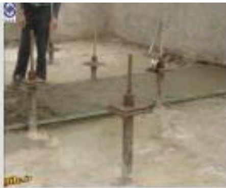
ریختن بتن مگر
