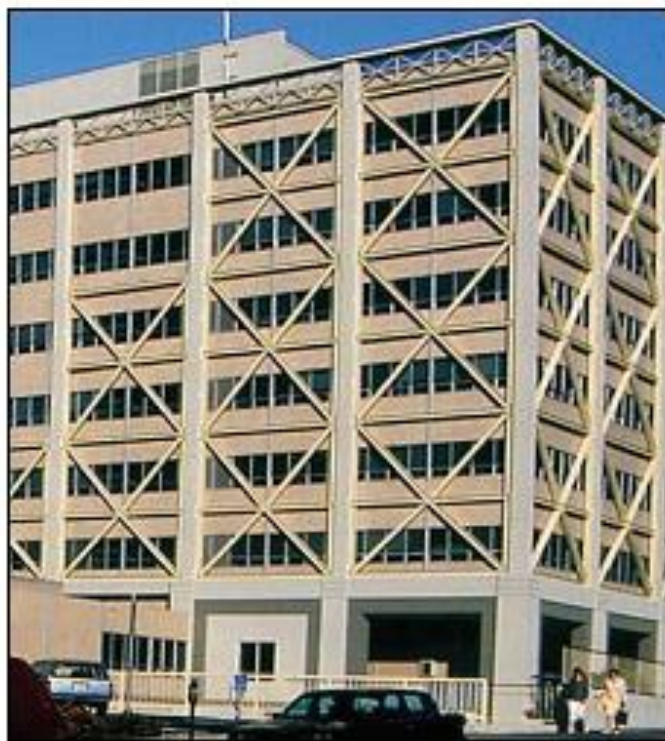
شکل ۳-۴- استفاده از مهاربندها بصورت نمایان در ساختمان‌ها
