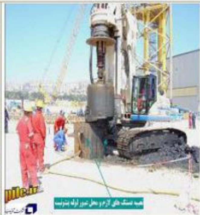
تعبیه دستک و محل عبور لوله بنتونیت
