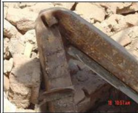
شکل ۱۹-۵-۲- نمونه ای از خرابی ستون های فولادی
