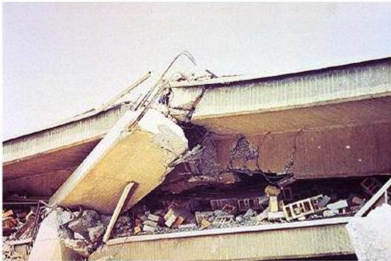
شکل ۱۰-۶-۲ وجود درز سرد در محل اتصال
