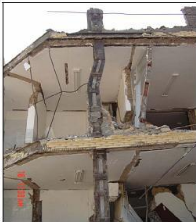
شکل ۲-۵-۳- نمونه ای از خرابی ستون های فولادی
