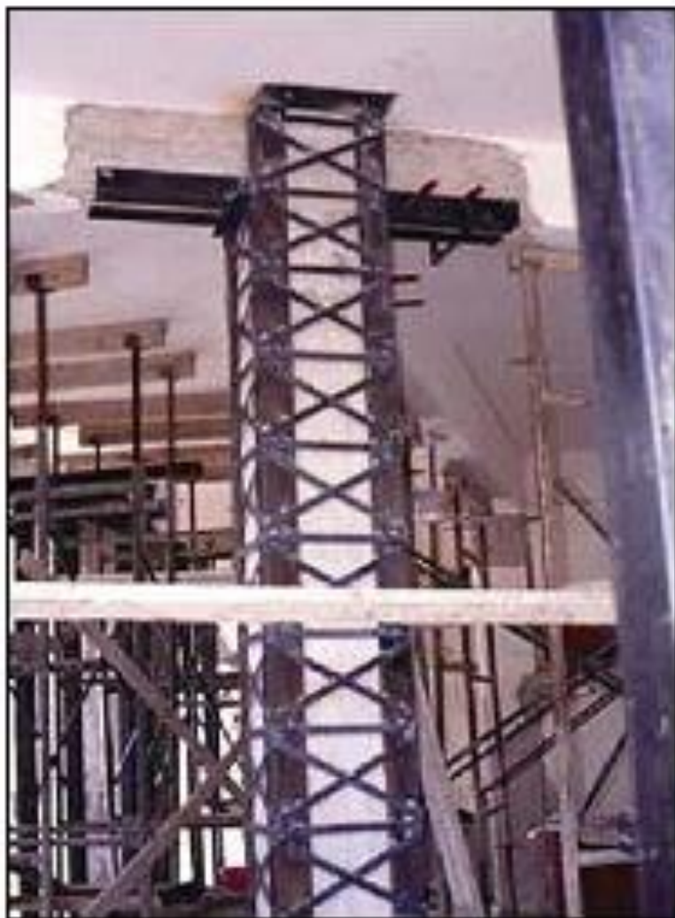
شکل ۲-۶-۲ روش‌های بهسازی اتصالات میانی
