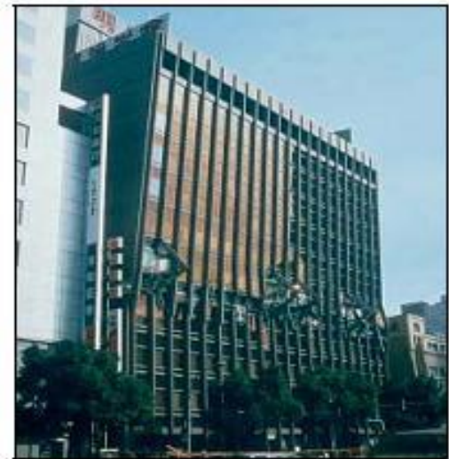
شکل ۳-۲- الف- وجود طبقه نرم در اولین تراز، ب- وجود طبقه نرم در طبقات بالایی
