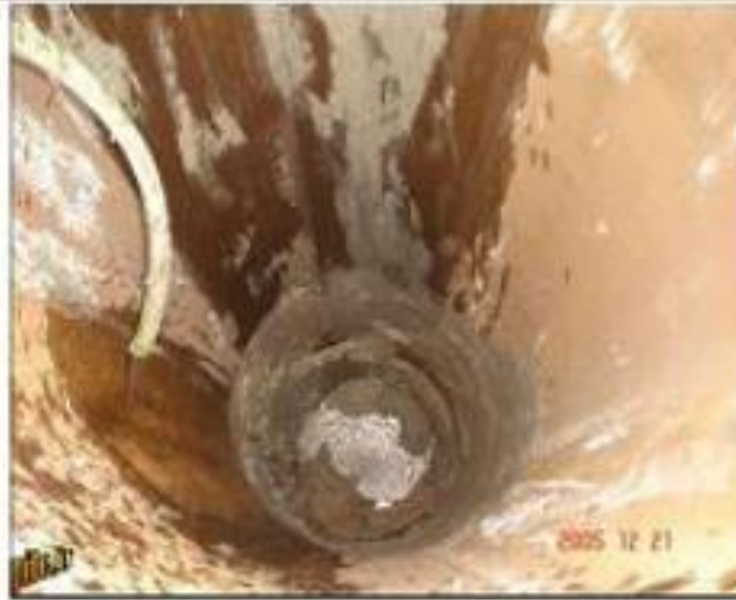
قرارگیری کیسینگ در دهانه شمع
