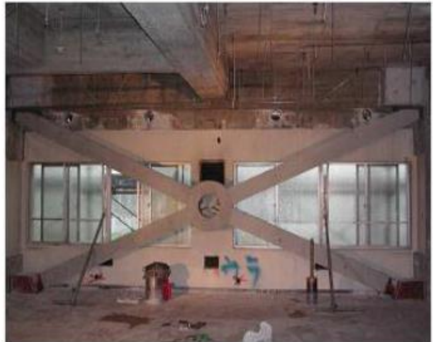
شکل ۴-۲۳- نمونه‌ای از مهاربند بتنی پیش‌تنیده و پیش‌ساخته
