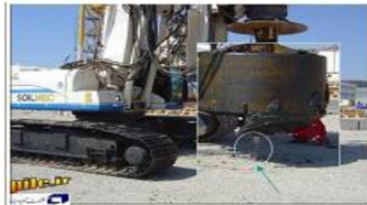
تراز کردن مته حفاری با محل شمع
