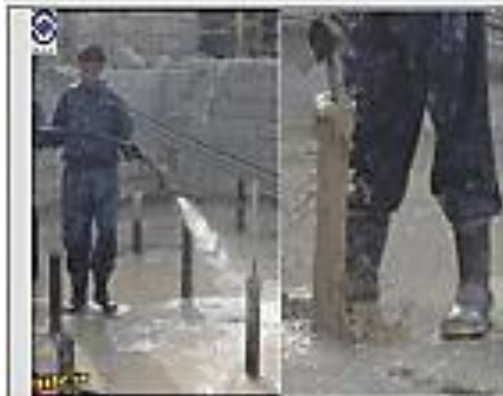
همچنین آب به درون لوله سبکروپایلی جهت خروج گل و لای درون آن
