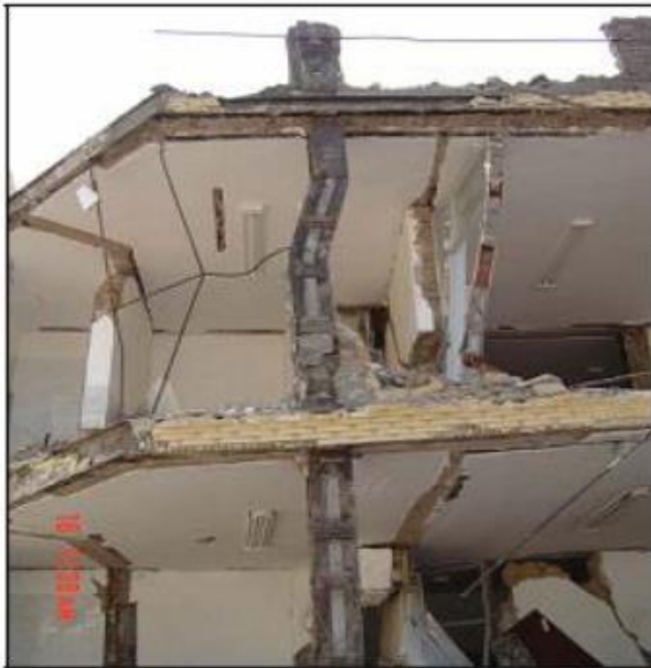
شکل ۱۹-۵-۲- نمونه ای از خرابی ستون های فولادی
