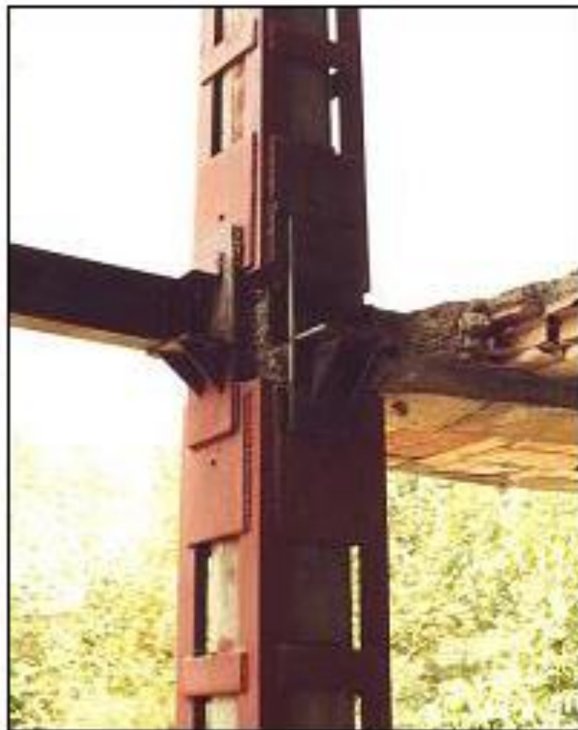
شکل ۲-۶-۲ روش‌های بهسازی اتصالات میانی
