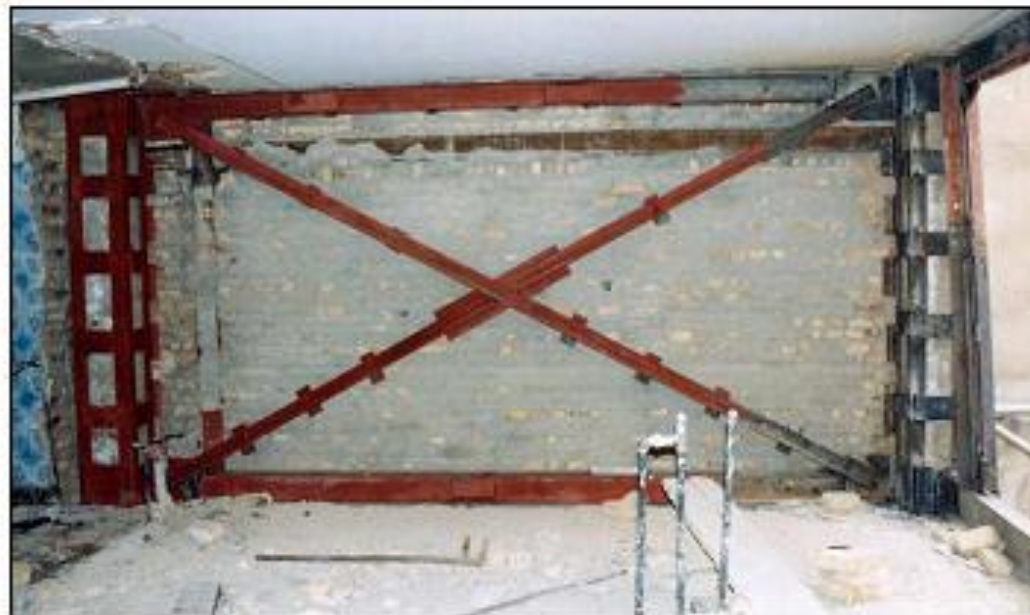
شکل ۴-۵- بهسازی قاب‌های موجود بوسیله مهاربندهای همگرا
