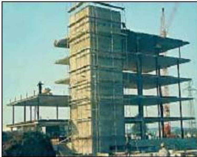
شکل ۳-۶- فاصله زیاد بین مرکز جرم و مرکز سختی و خرابی ناشی از ایجاد پیچش
