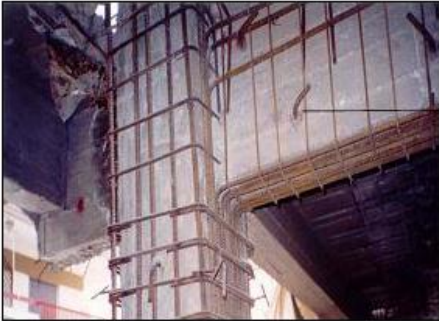
شکل ۲-۶-۲۳ اجرای روکش بتنی در اطراف اتصال خارجی (اداعه)
