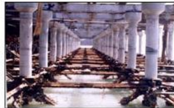
شکل ۲-۵-۲۳- بهسازی ستون‌های با خوردگی شدید با روکش بتنی
