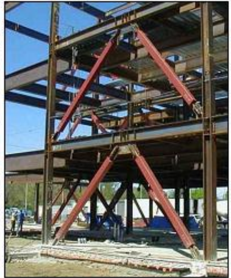
شکل ۴-۱۹- نمونه‌هایی از مهاربند ضد گمانش BRBF
