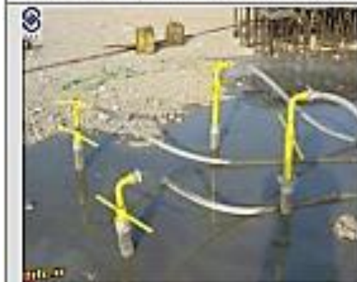
تزریق تحت فشار دوشاب به درون لوله سبکروپایلی
