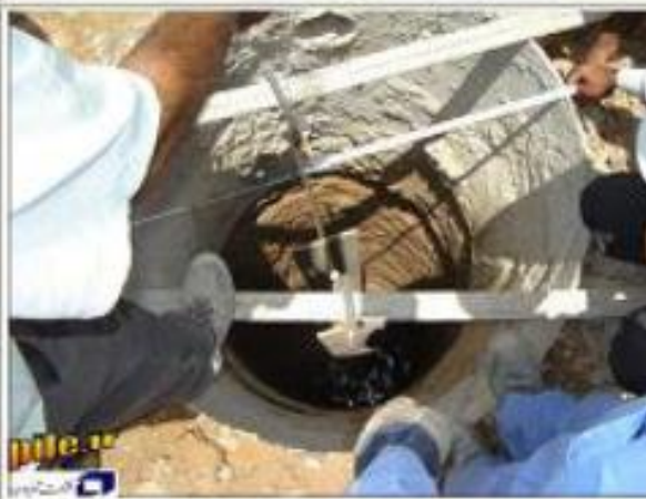
شاقول کردن پروفیل برای قرار گرفتن در مرکز شمع
