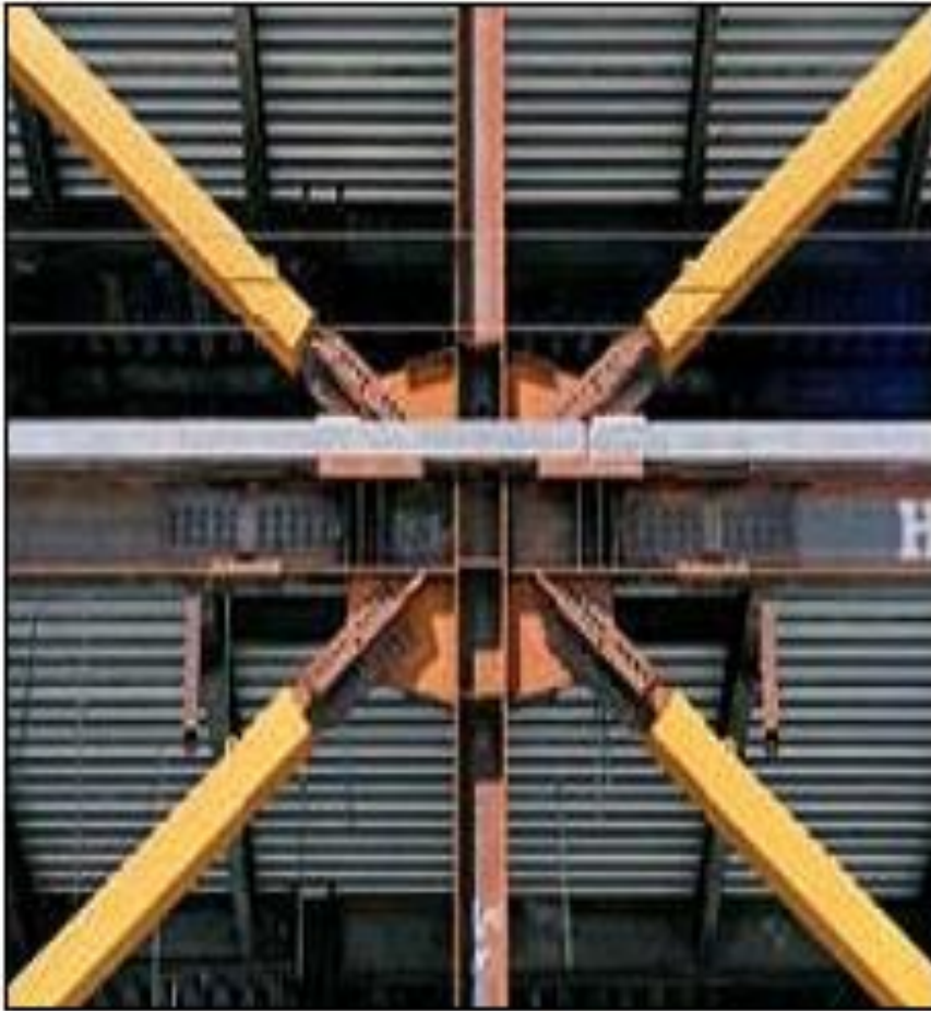
شکل ۴-۱۹- نمونه‌هایی از مهاربند ضد گمانش BRBF
