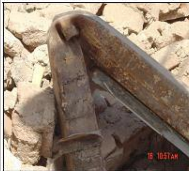
شکل ۲-۵-۳- نمونه ای از خرابی ستون های فولادی
