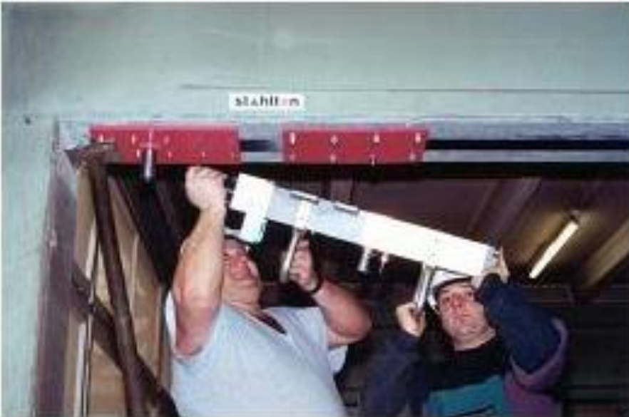
شکل ۲-۴-۱۷- روش پیش تنیدگی در صفحه FRP
