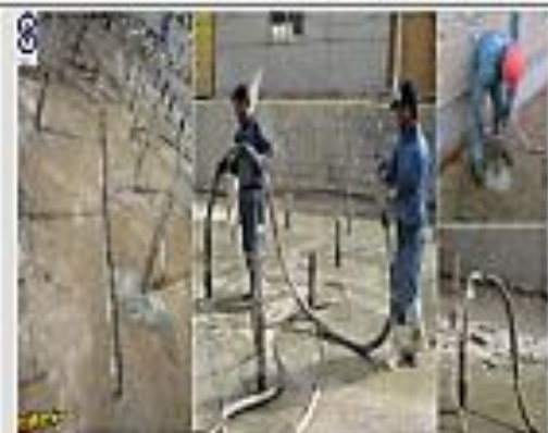
جاگذاری بکر جهت تزریق دوشاب به درون لوله
